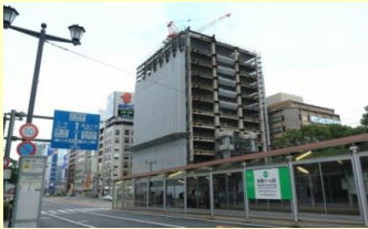
建造物躯体・壁面点検
